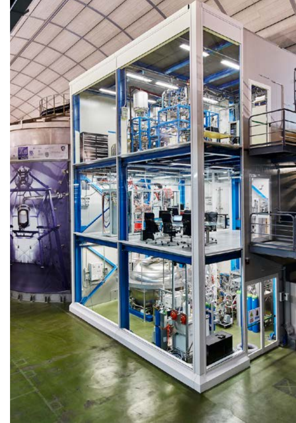
وتتضمن البنية التحتية المشيدة تحت الأرض لكاشف XENONIT خزناً مائياً وتروموسنات لتنظيم الحرارة المنخفضة ومجموعة من الأجهزة الإلكترونية وخزان غازي ومعدات لتنقية المياه.
